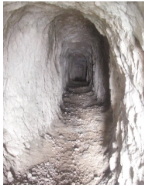
5. La lunga galleria (60 metri) con postazione che da Col d'Astiago scende lungo la linea di sbarramento alla Forcella di Val d'Ancino, quota 1090.
